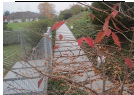
Luminaire sous tension 230V et sans DDR !
